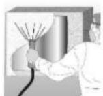
Jetzt können, wie auf Seite 5 beschrieben, die Oberflächen mit Firetex® Concrete WB beschichtet werden.
