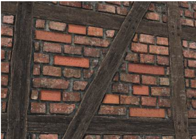
② Ersetzen oder Ergänzen beschädigter Steine mit RM pro
