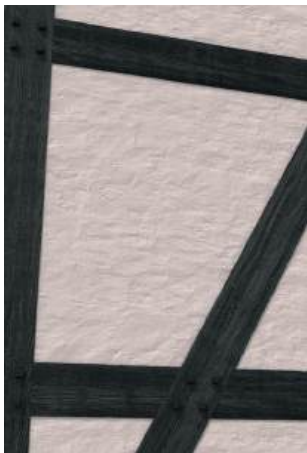
③ Grundieren mit Primer Hydro SF und anschließend beschichten mit Color CL Historic
