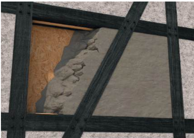
② Einbringen von Fachwerkmörtel
