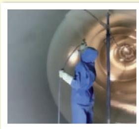
Je nach Anwendungsbereich und Objekt können **AB-COR® 950 SW**, **AB-COR® 950 SW-H**, **AB-COR® 955 SW** und **AB-COR® 955 SW-H** ein- oder mehrschichtig aufgebracht werden. Die Verarbeitung der **AB-COR®**-Produkte erfolgt hauptsächlich im 1-K-Airless-Spritzverfahren.
